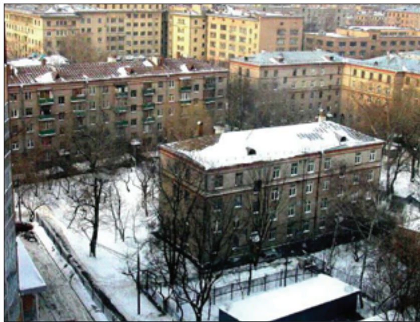
Жилой дом до реконструкции.
