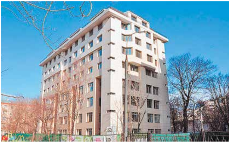
Дом на улице Мишина, 32 после реконструкции
